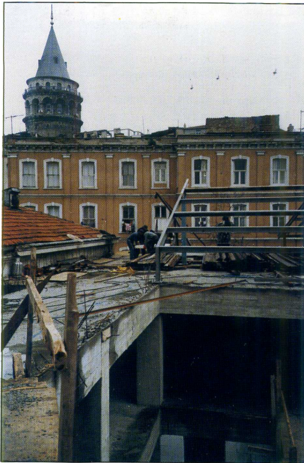
Les travaux se poursuivent ...
